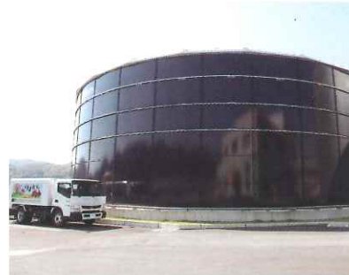
消化液貯留槽
